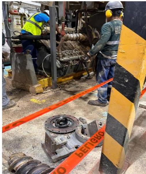
Figura 2.25 Personal contratista cambiando el tornillo de extrusora de línea 2
