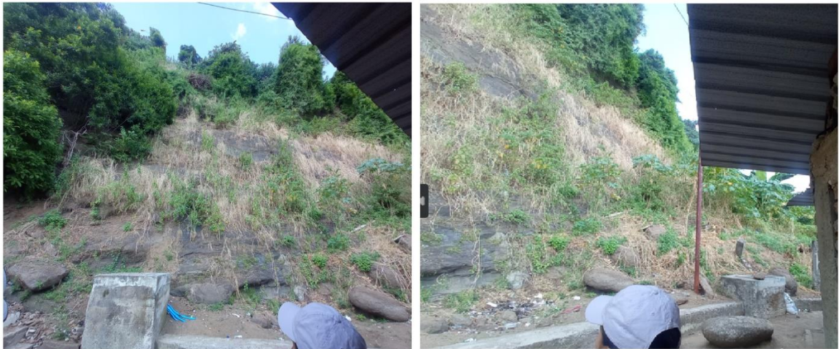
Figura 9. Deslizamiento tipo caída de roca
