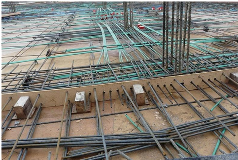
Figura 2.2 Sistema de postensado no adherido en sitio
