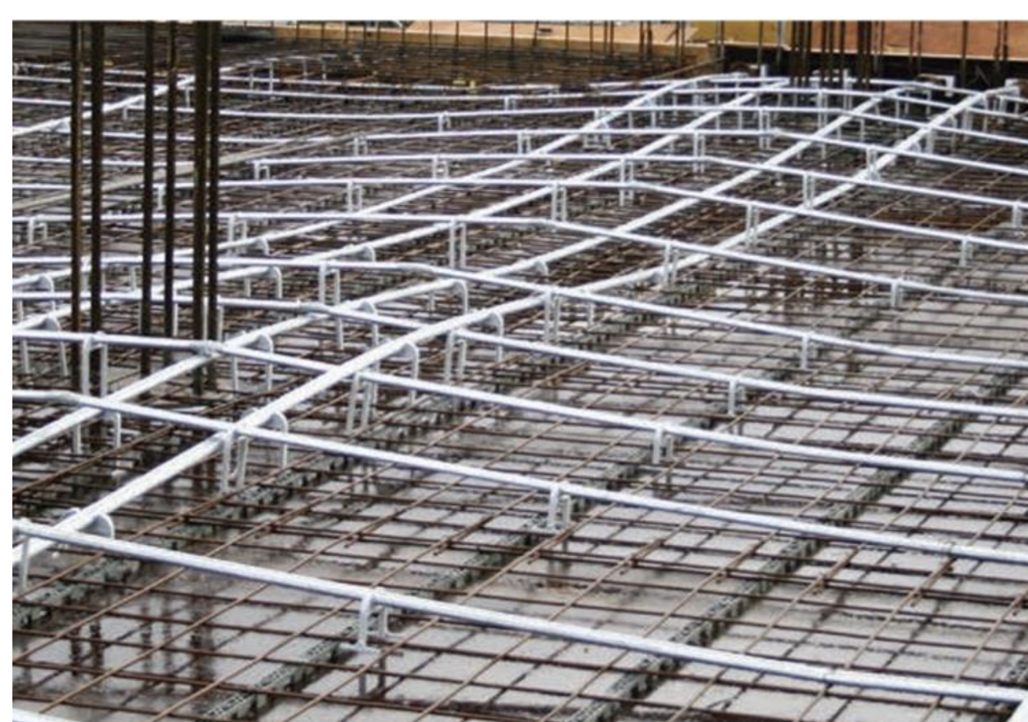
Figura 5. Configuración de los tendones de presfuerzo obtenidos de CCL (2016).
