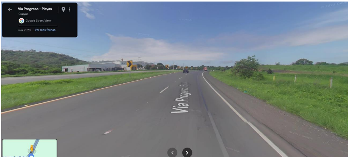
Tramo recto vía a Villamil Playas antes de entrar a la curva.
