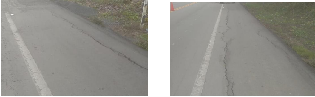
Figura 17. Fisuras Longitudinales
