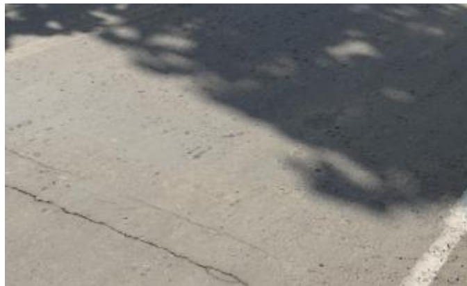
Figura 7. Fisuración transversal.
