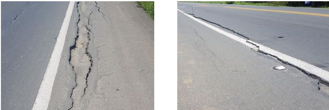
Figura 18. Fisuras Longitudinales
