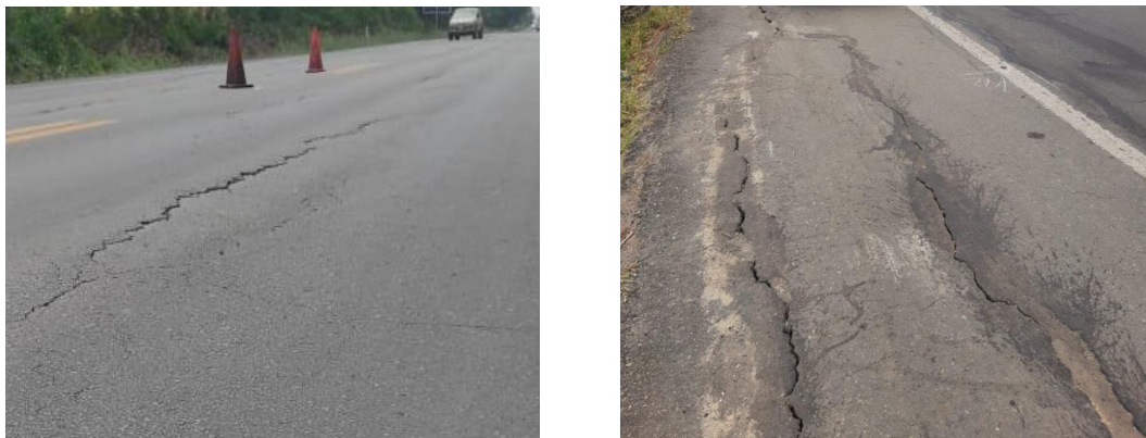
Figura 16. Fisuras Longitudinales
