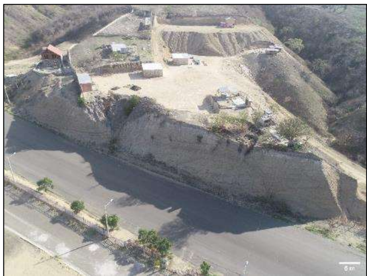
Figura 3. Talud en km 1.6 en la vía San Mateo - Santa Marianita, del cantón Manta.
