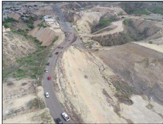
Figura 39. Fotografía Aérea del inicio del talud colapsado en km1.9 de la vía San Mateo - Santa Marianita.
