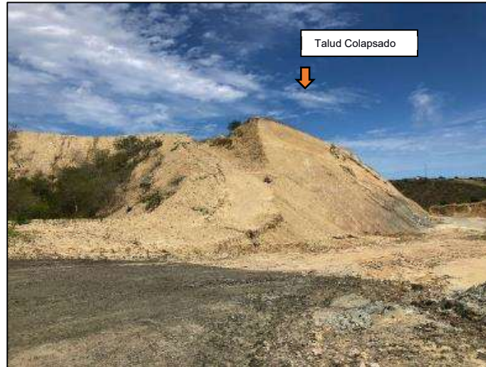
Figura 22. Talud en Abscisa 1+900 de la vía San Mateo - Santa Marianita
