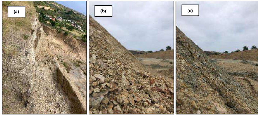
Figura 24. Materiales que componen el talud del km1.9: (a) granos finos en la parte superior del talud, (b) detritos color amarillento en laterales del pie de talud, (c) detritos color gris verdoso en centro del pie de talud.
