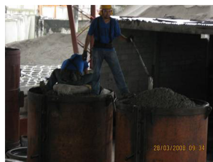
Foto 2.1.3.11 Acomodamiento del hormigón en el molde de la tubería
