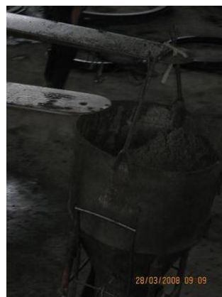
Foto 2.1.3.5 Transportación de la tolva con el hormigón
