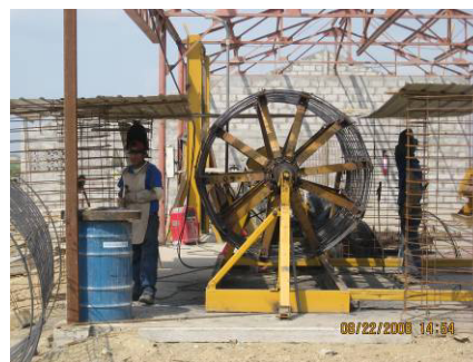
Foto 6.2 Proceso de doblado de la malla
