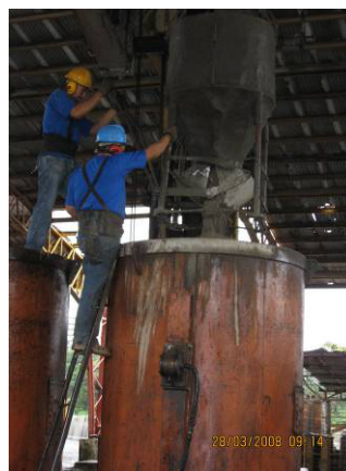
Foto 2.1.3.6 Relleno vertical del molde de la tubería
