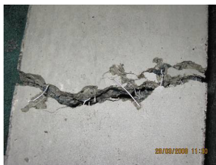
Foto 3.4.3 Comportamiento del hormigón reforzado con fibras y representación de la tenacidad del mismo
