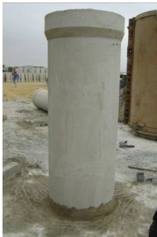
Foto 5.2.3.1 Tubería asentada sobre el espigo de la misma
