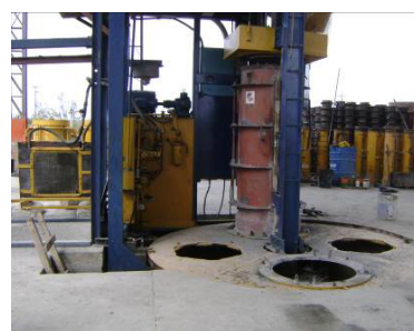
Foto 2.1.3.15 Base sobre la que se colocan los moldes
