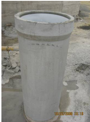
Foto 5.2.3.3 Tubo lleno de agua sin presencia de humedad en sus paredes externas
