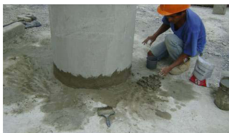
Foto 5.2.3.2 Preparación del mortero hidráulico (Maxiplug)
