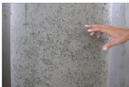
Foto 5.1.11 Aspecto exterior de la tubería de 24" H.R.F.
