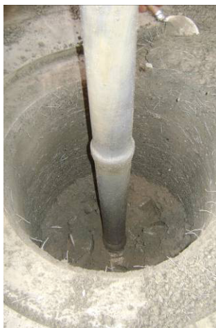
Foto 5.1.6 Colocación del hormigón en el molde de la tubería
