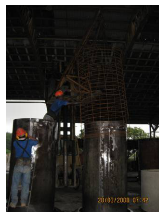
Foto 2.1.3.8 Colocación de la canastilla metálica
