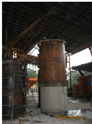
Foto 2.1.3.12 Desmolde de una tubería de 1.000 milímetros
