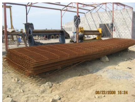
Foto 6.1 Mallas en forma de planchas antes de ser dobladas
