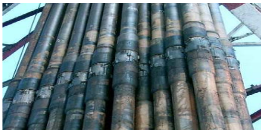
Figura 24 Instalación de los LoTAD en una parada de una sarta de perforación del pozo Saha-169D
