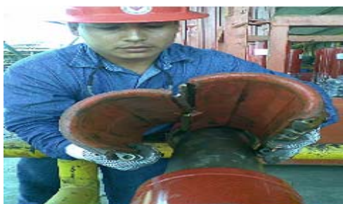
Figura 30 a correcta de la ubicación de todo el conjunto de piezas en el substituto de tubería, cortesía de weatherford
