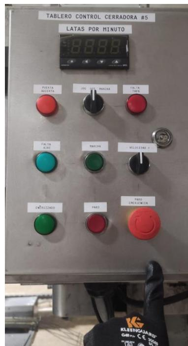
*Nota:* La siguiente imagen muestra el tablero de control con los nuevos botones de paro de emergencia y las funciones de seguridad implementadas.
