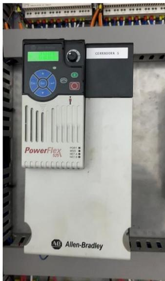
*Nota:* La imagen a continuación muestra el variador de frecuencia PowerFlex 525 instalado en el tablero de fuerza, el cual ha sido clave en la optimización del sistema de cerrado.
