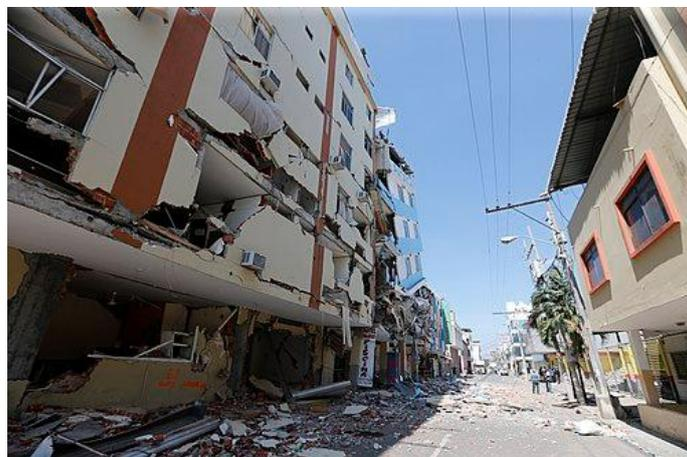
**Figura 1.1. Grietas en edificios debido a eventos sísmicos**
