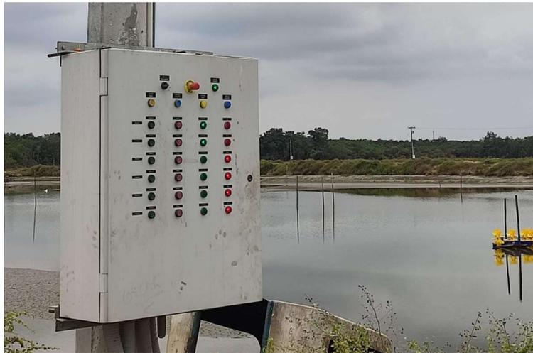
**Figura 2.34 Instalación de Tablero de Aireadores.**
