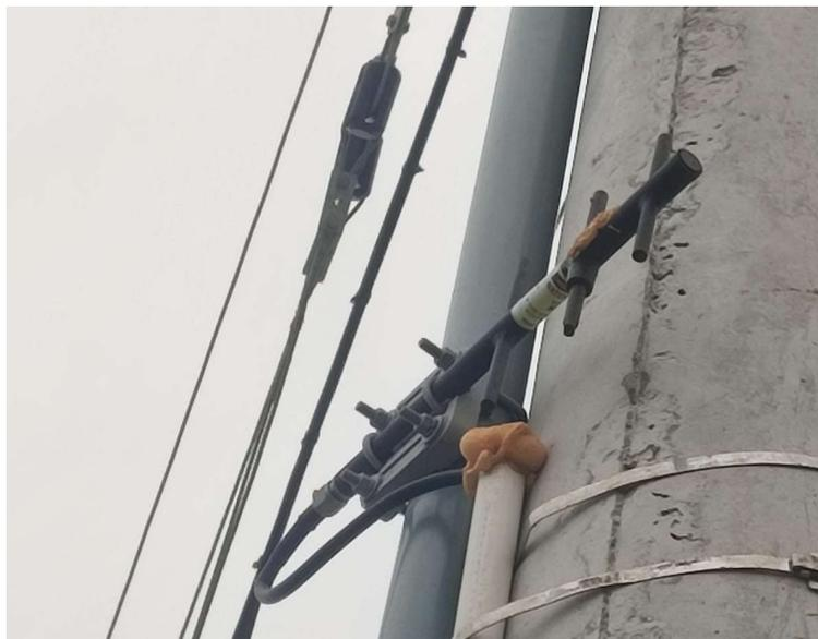
**Figura 2.35 Instalación de Antenas Remotas para cada Tablero de Aireadores.**
