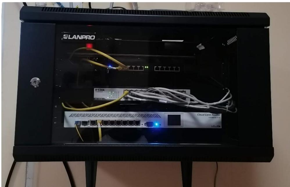
Figura 3.25 Instalación del RB4011iGS+RM en el Nodo Simiatug
