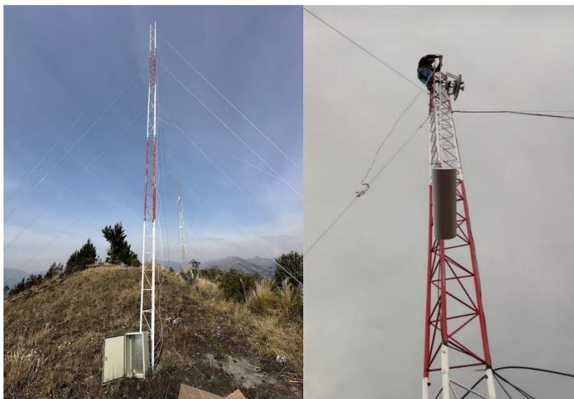
Figura 3.27 Montaje de equipos en la Torre Cutahua
