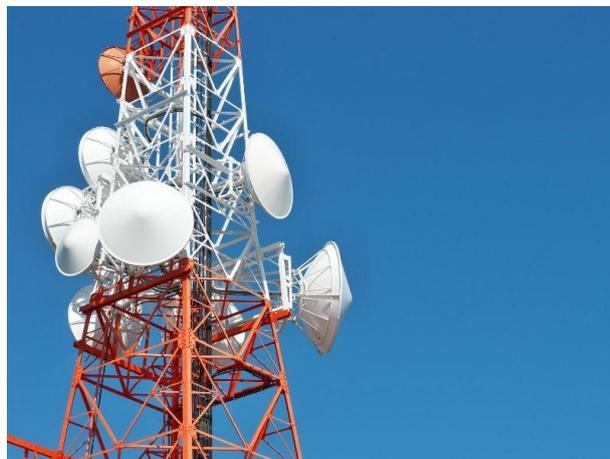
Figura 2.6 Antenas Direccionales [20]
