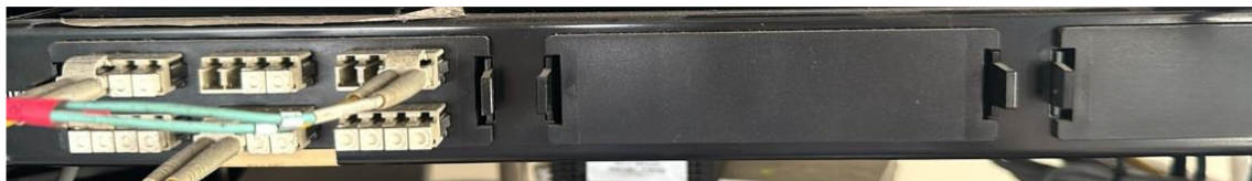
Ilustración 31 Fiber Connect Panel del Datacenter (Zapata Jose)
