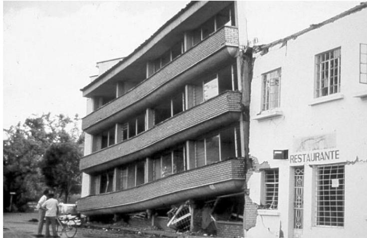
Figura 4. Colapso de estructura con irregularidad en elevación, (ResearchGate, s/f)
