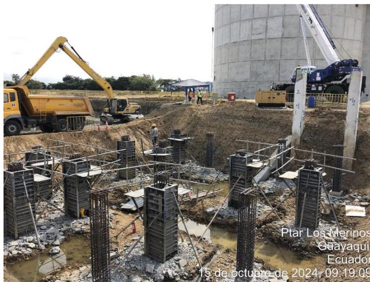
Figura 2.4 Ejemplo de cimentación con pilotes, zona de descabezado y recrecido de pilotes.
