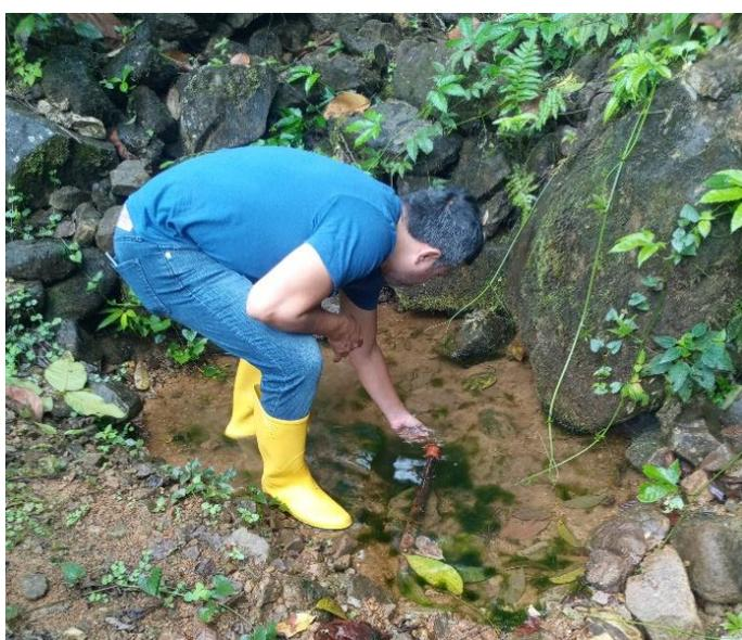
**2.4.1.2 Distribución:** En cuanto a la distribución, las tuberías que transportan el agua recorren los senderos de la propiedad que conducen hacia las quebradas. Esta disposición expone a las tuberías a riesgos geológicos, ya que se encuentran en zonas susceptibles a deslizamientos de tierra. La presencia de estos deslizamientos podría afectar la integridad de las tuberías, ocasionando roturas o desplazamientos comprometerían la funcionalidad del sistema de abastecimiento.
