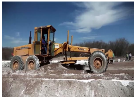
Figura 2.7 Técnica de mejoramiento con Cal. (HORCALSA, 2020).
