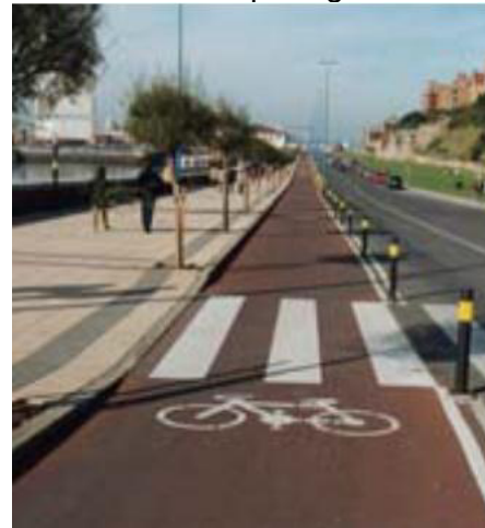
Figura N° 6 Carril bici protegido
