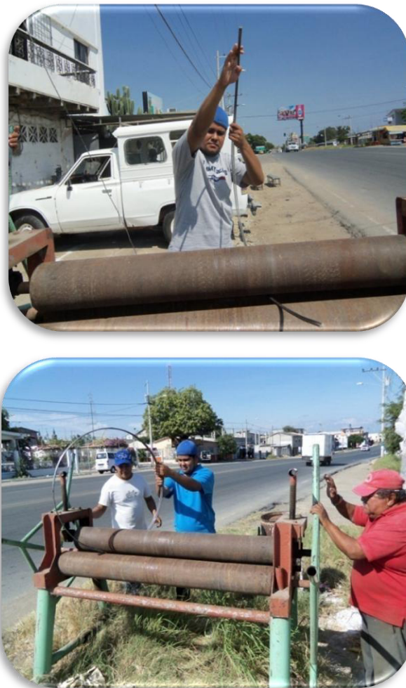
Figura N° 26 Introducción de las varillas en la rola. 26
