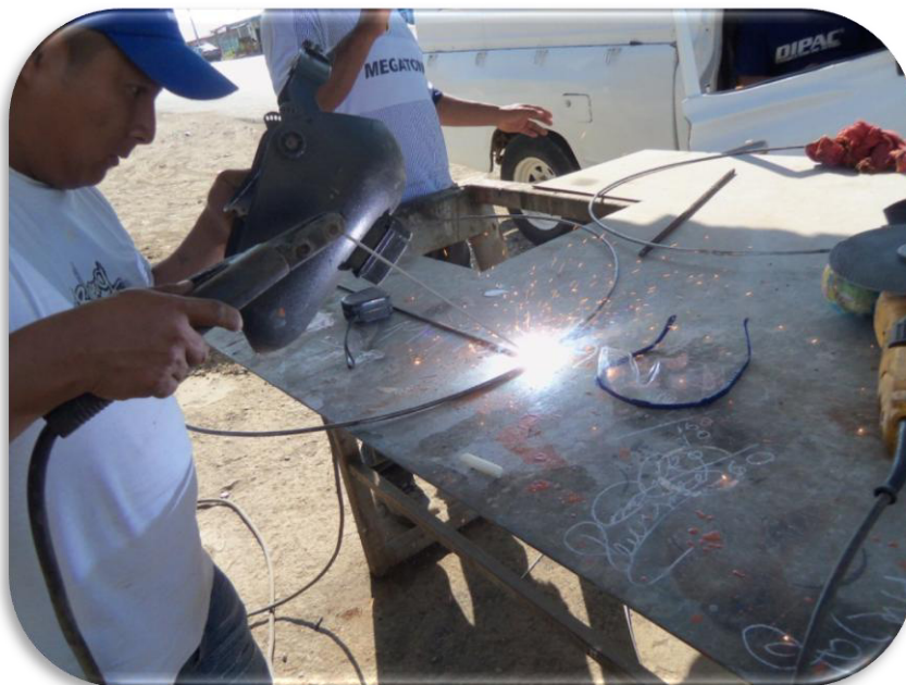
Figura N° 27 Proceso de soldadura. 27
