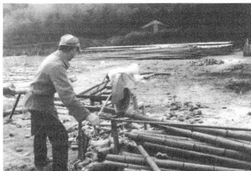
**B. Latilladora:** Esta máquina, servirá para cortar las cañas en latillas, para producir los laminados para paneles para pisos. La máquina se calibra de acuerdo al número de latillas que se quieran obtener.
