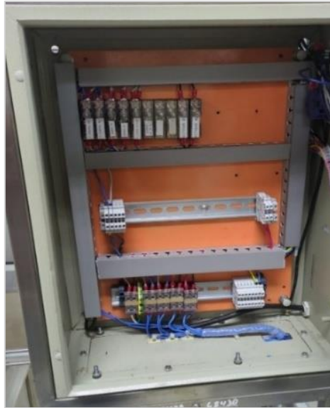
Figura 2.4 Tablero eléctrico recableado luego del levantamiento inicial (Autor propio, 2025)
