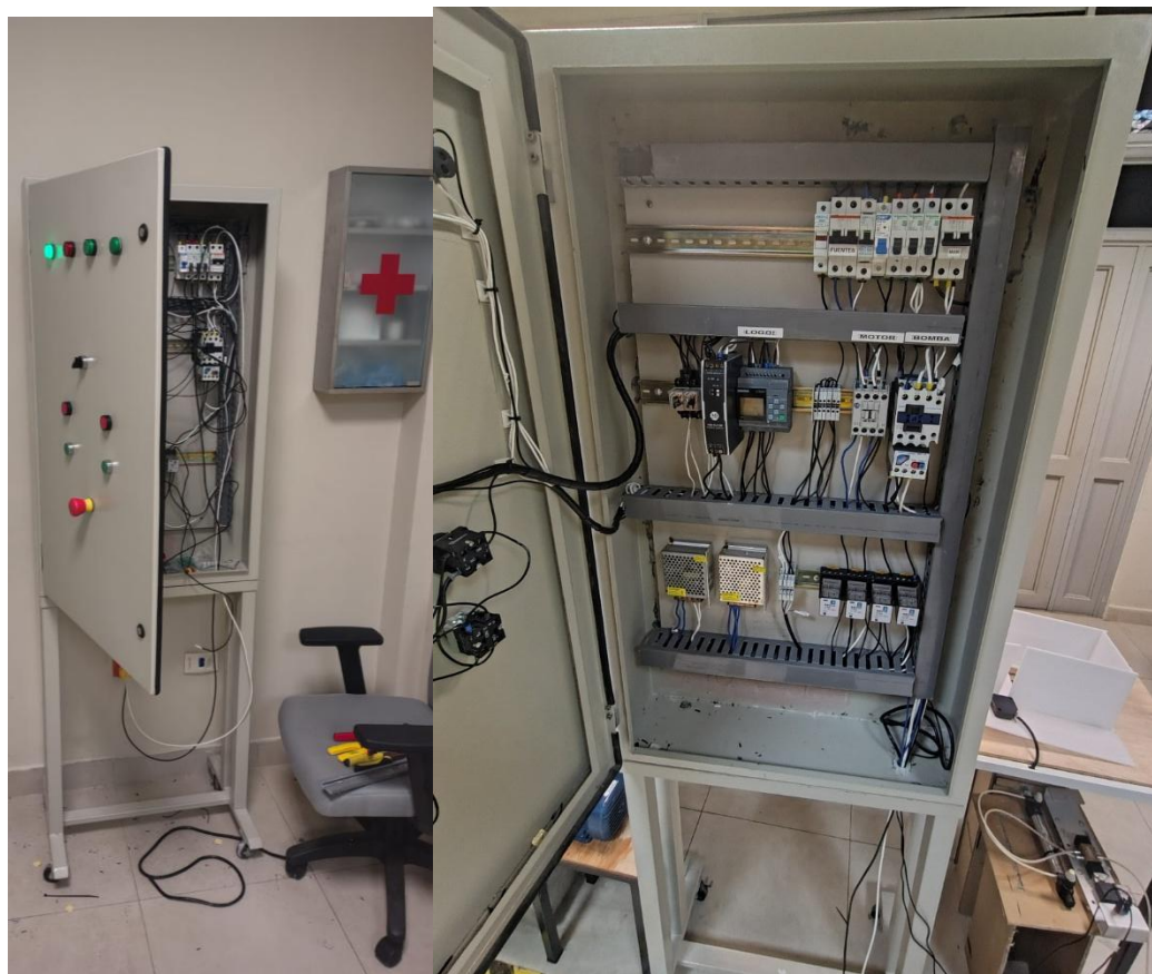
Comprobación y peinado de tablero eléctrico
