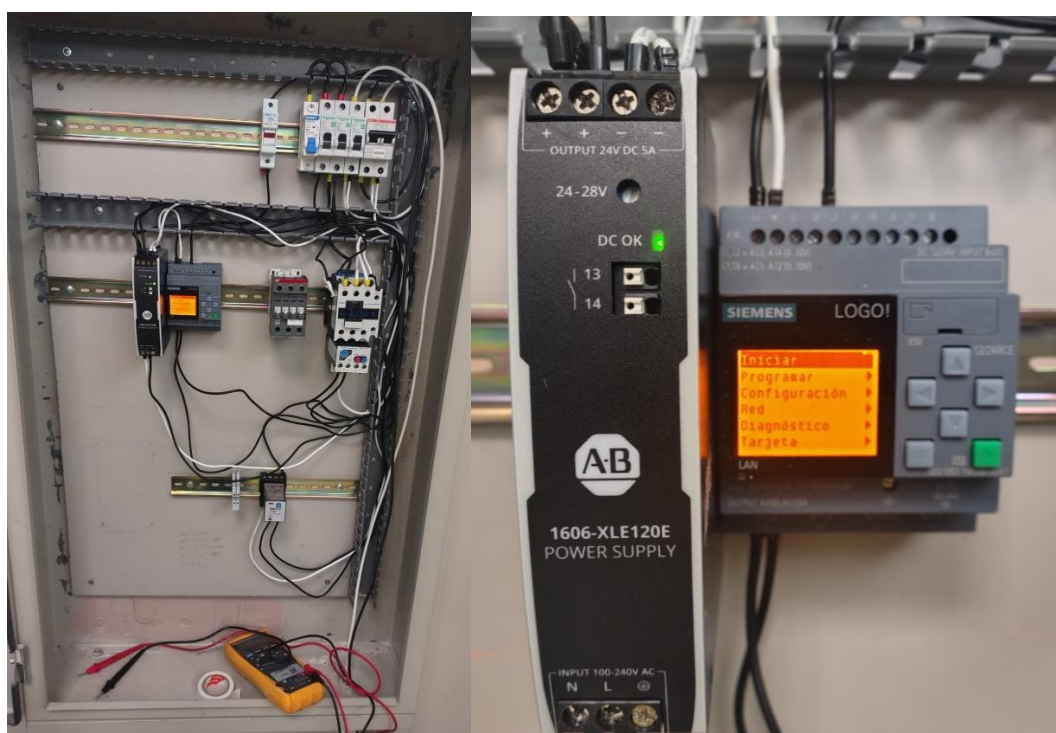
Comprobación de las conexiones del logo
