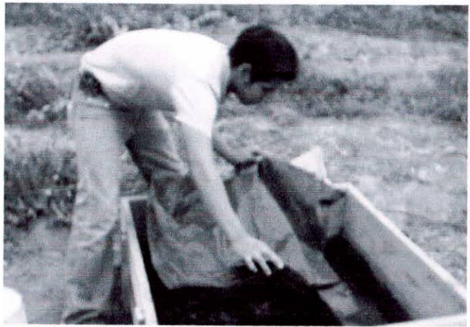
FIGURA 2.7.- COLOCACIÓN DE LÁMINA DE POLIETILENO NEGRO, LUEGO DE DESAPARECER EL AGUA SUPERFICIAL.
