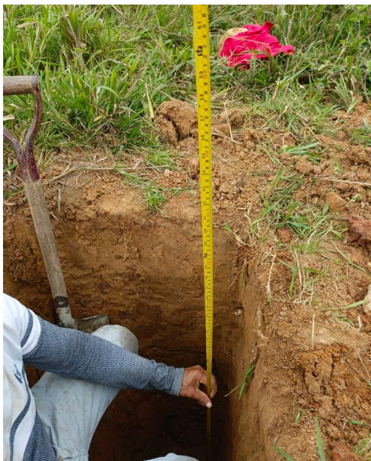
Figura 9 Muestra de la calicata 4 medida a 1 metro de profundidad
