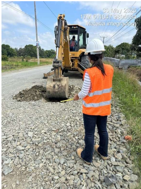
Figura 12. Primera calicata realizada.
