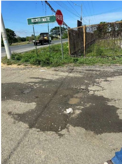
Figura 3. Punto de inicio del tramo de acceso a El Mate.
