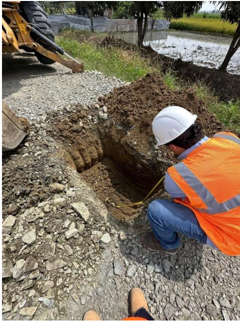
Figura 15. Estratigrafía de la segunda calicata
