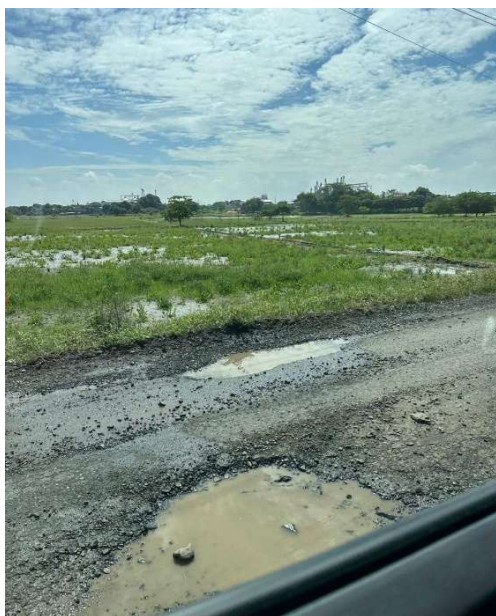
Figura 5. Presencia de “Baches profundos en medio de la vía.
