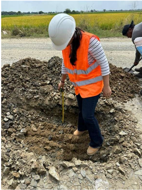
Figura 16. Tercera calicata realizada in-situ
