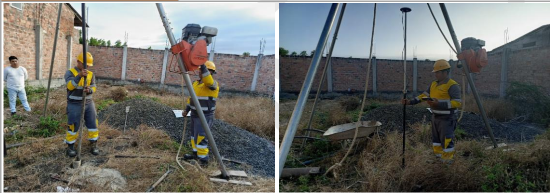
ENSAYO DE SPT 2
