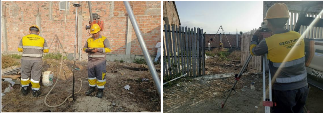
ENSAYO DE SPT 1
