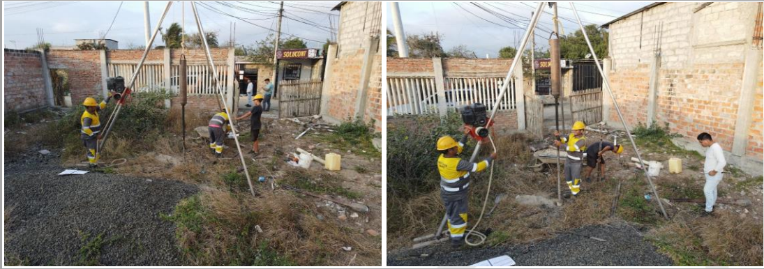
ENSAYO DE SPT 2
