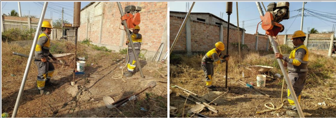
ENSAYO DE SPT 1
