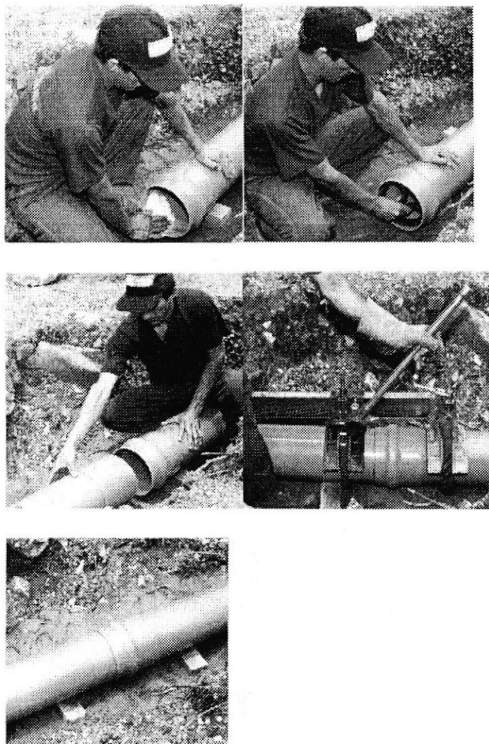
Figura 3.35 Secuencia de Unión Mecánica
