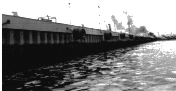
FIGURA 2.1. VISTA GENERAL DEL TABLESTACADO
