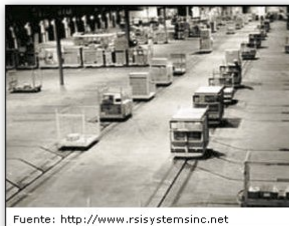
Imagen 2.8 Cintas por cable enterrado
