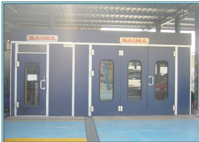
Sección de Pintura Elaborado por los autores
