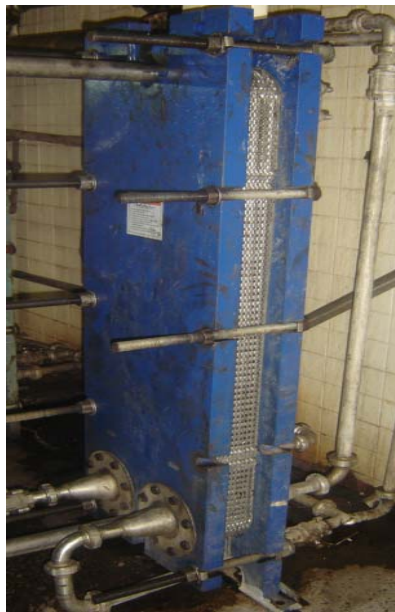
FIGURA 2.21 INTERCAMBIADOR DE CALOR DE PLACAS
