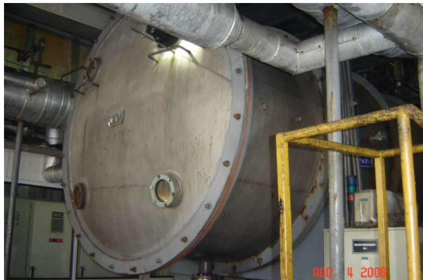
FIGURA 2.27 CONDENSADOR BUNDLES
