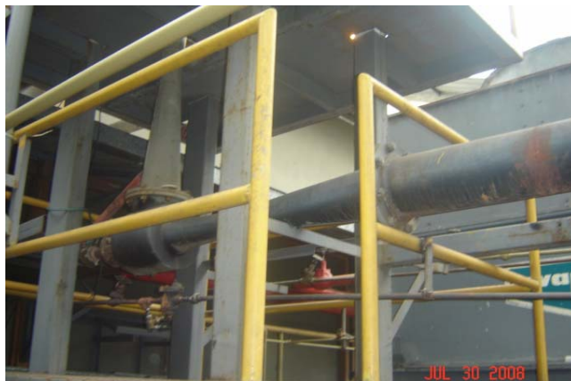
FIGURA 2.22 SISTEMA JET EYECTOR DE DOS ETAPAS
