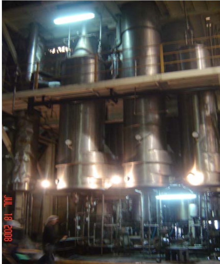
FIGURA 2.17 EVAPORADOR TUBULAR DE TRES EFECTOS
