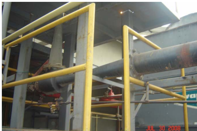
FIGURA 2.22 SISTEMA JET EYECTOR DE DOS ETAPAS
