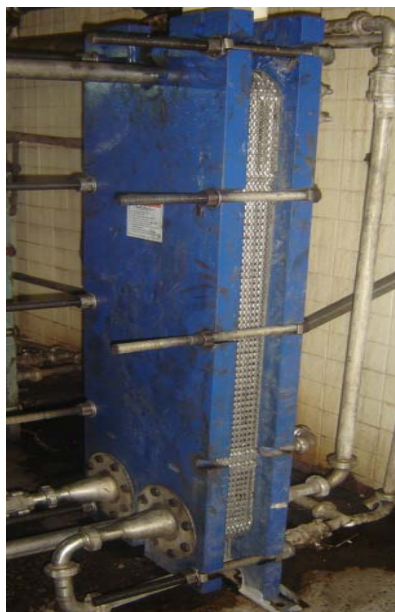
FIGURA 2.21 INTERCAMBIADOR DE CALOR DE PLACAS
