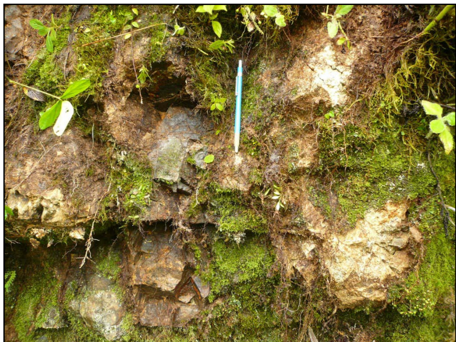
Fotografía 5.6. Pórfido dacítico en contacto con un cuerpo andesítico, afloramiento sumamente fracturado.
