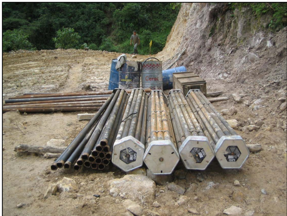
Fotografía 7.10. Tubería de perforación NQ y HQ.
