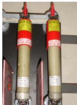
FIGURA 3 – 17: FUSIBLES TIPO NX
