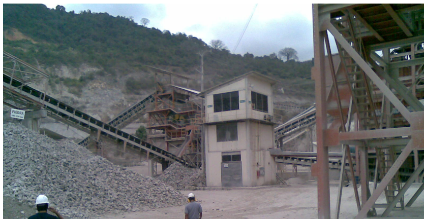
Figura #7 Subestación “Trituración Secundaria”
