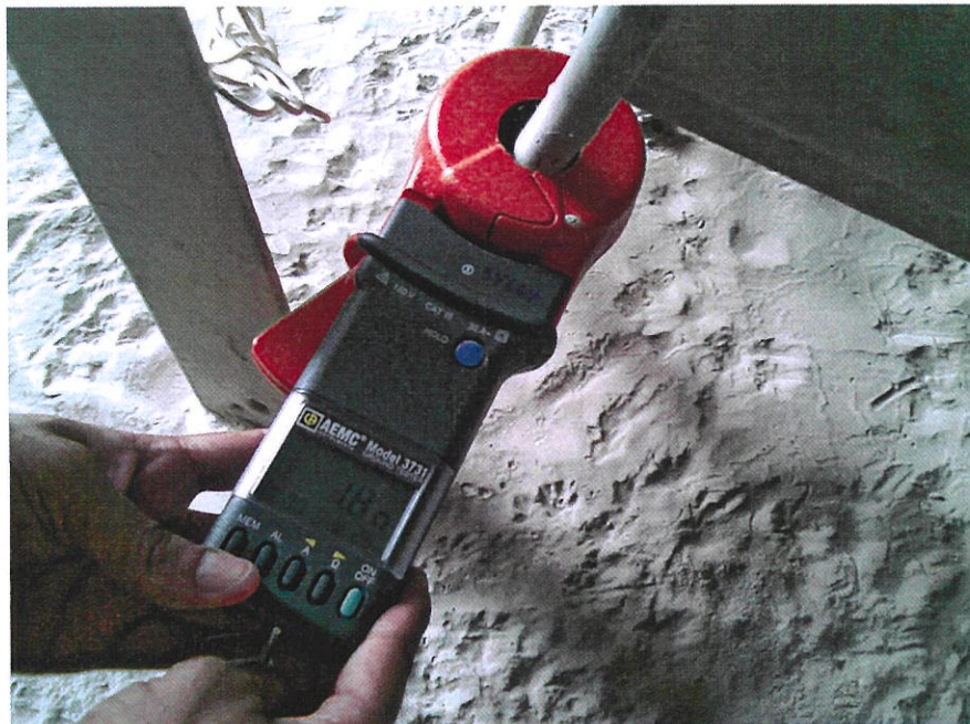
Figura #5 Resultado de la medición en el Transformador de Trituración secundaria
