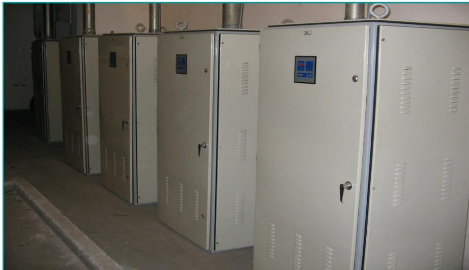
**Figura 1.7. Bancos de capacitores del HRGE.**
