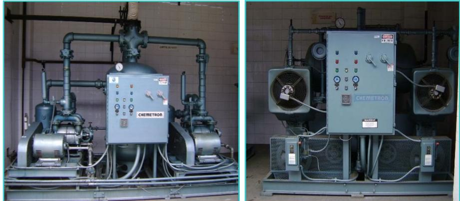
**Figura 4.24. a) Central de vacío. b) Central de aire.**
