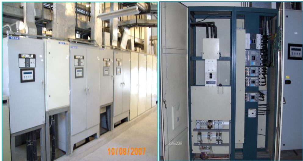
**Figura 1.5. Tableros de Transferencia Automática y breakers principales.**
