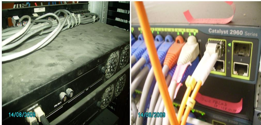
**Figura 3.22. Equipos de comunicación Catalyst 2960.**
