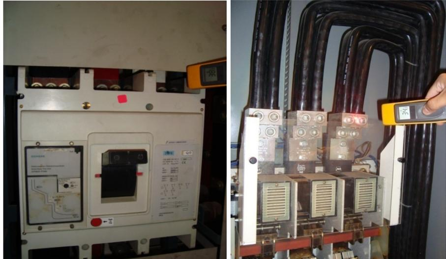
**Figura 1.3. Temperaturas en tablero principal y TTA 2.**
