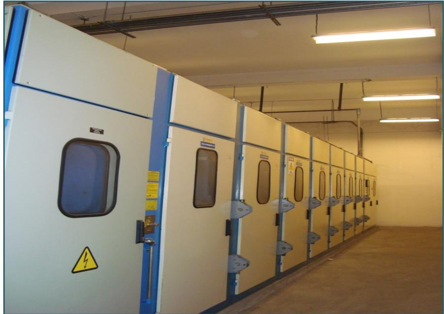
**Figura 1.1. Celdas eléctricas de distribución.**
