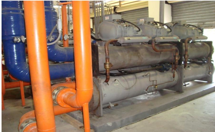
**Figura 4.28. Equipos de refrigeración chillers**
