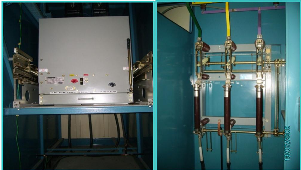
**Figura 1.6. Breaker G.E. Type VB1 y protecciones de media tensión.**
