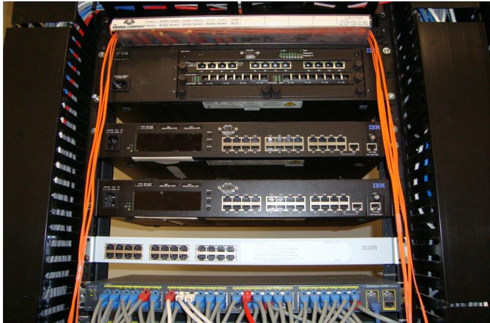
**Figura 3.20. Cableado tipo UTP y fibra óptica.**
