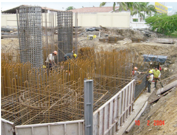
Figura 5.1.- Muestra el armadura de la zapata, parte de la sub-estructura del puente.
