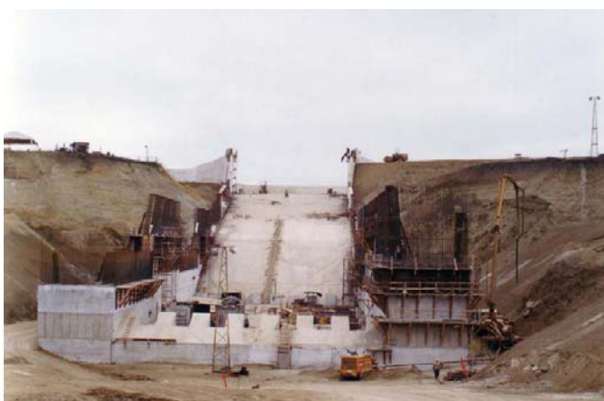
Fotografía 2.3.- La fotografía muestra el aliviadero de la Presa San Vicente. (Fuente: CEDEGE, presentación proyecto: Complejo Hidráulico San Vicente, página 3)
