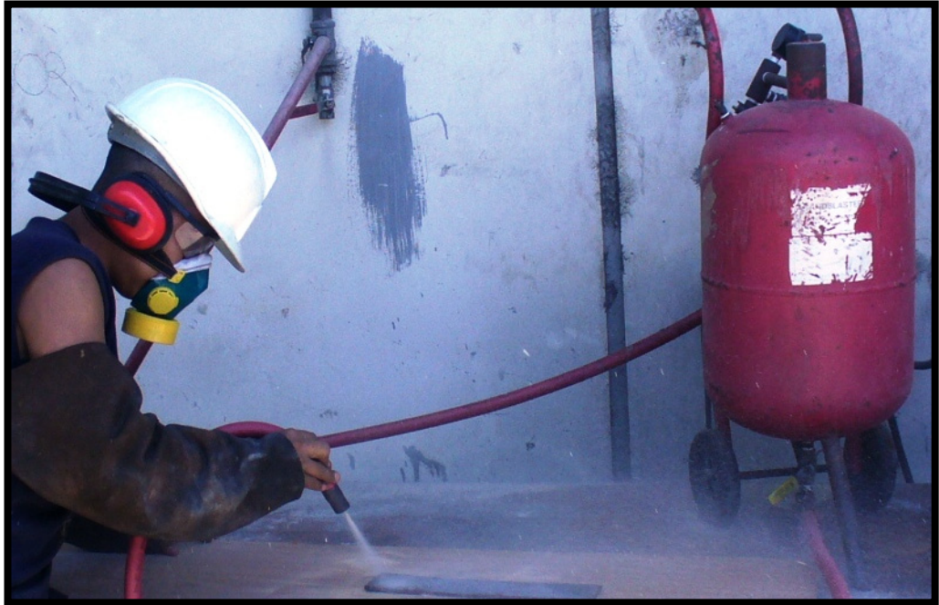
FIGURA 2.5 LIMPIEZA CON SANDBLASTING (ARENA A PRESION)
