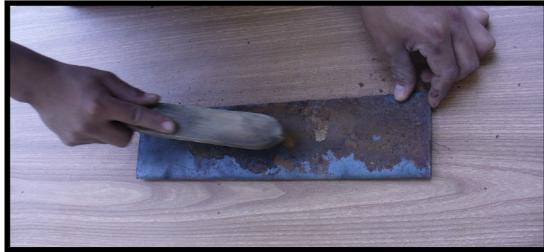
FIGURA 2.7 LIMPIEZA METALICA USANDO CEPILLO
