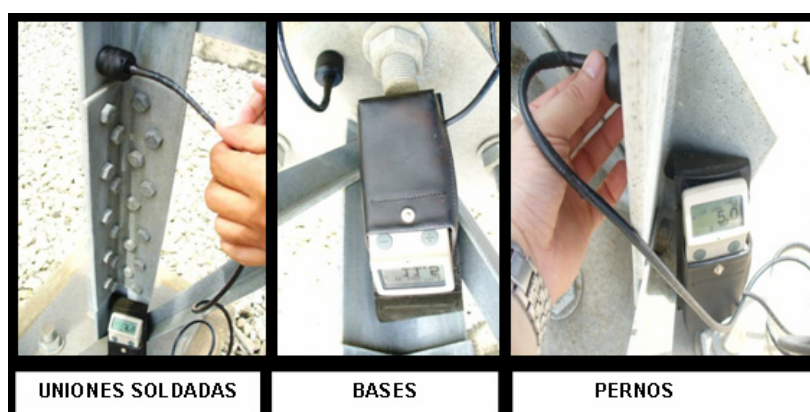
FIGURA1.5 MEDICIÓN DE CORROSIÓN DE UNIONES SOLDADAS, BASES Y PERNOS
