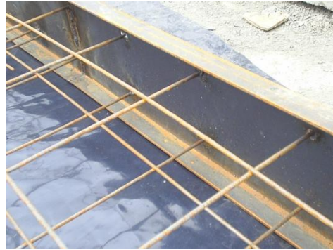
FIG. 5.8 Soldadura de mallas al perfil
