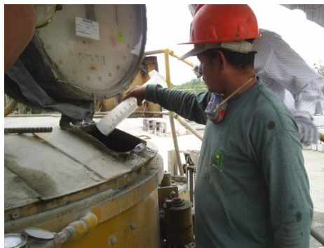
FIGURA 5.16 Colocación del aditivo
