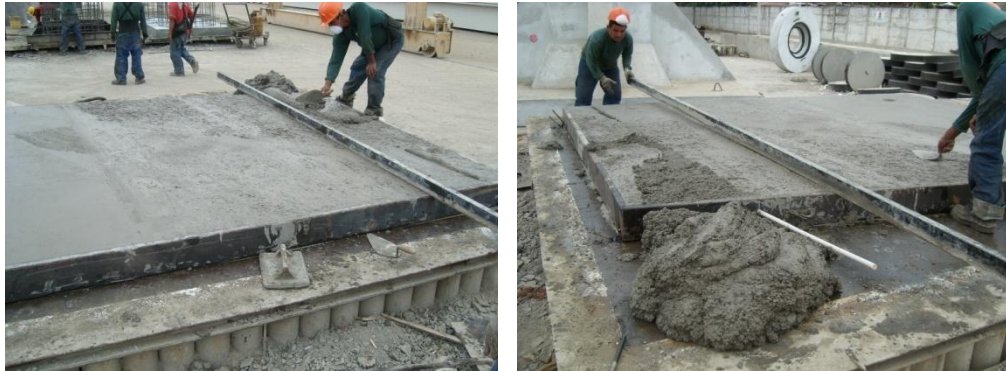
FIGURA 5.19 Enrasamiento y alisado final del panel
