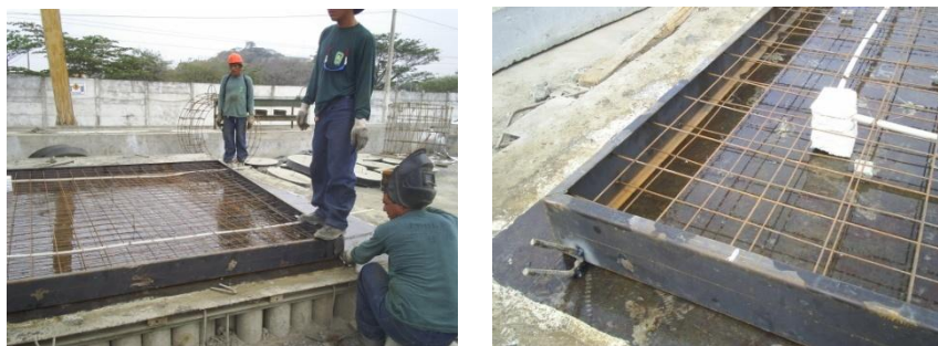
FIGURA 5.13 Soldadura de soportes a las bases del panel
