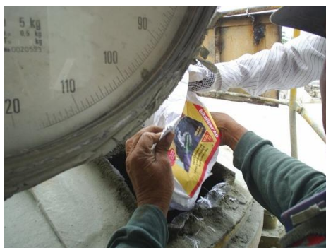
FIGURA 5.15 Colocación de agua y fibra de polipropileno
