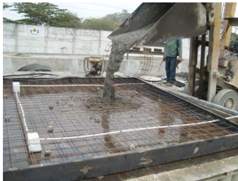
FIGURA 5.17 Transporte del Hormigón Liviano mediante el bobcat
