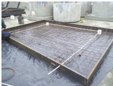
FIGURA 5.11 Instalación de tubo PVC eléctrica al panel
