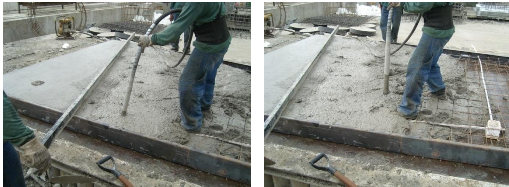
FIGURA 5.18 Compactación del Hormigón Liviano
