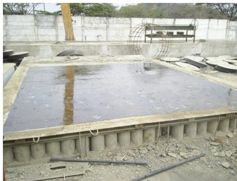
FIGURA 5.9 Colocación de diesel a la plancha metálica
