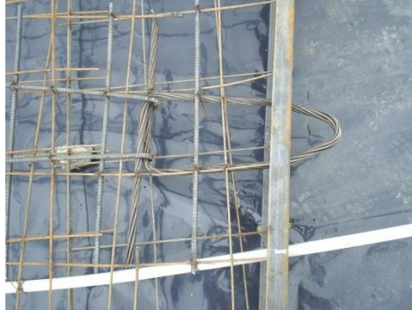
FIGURA 5.12 Sujeción de pasadores al panel
