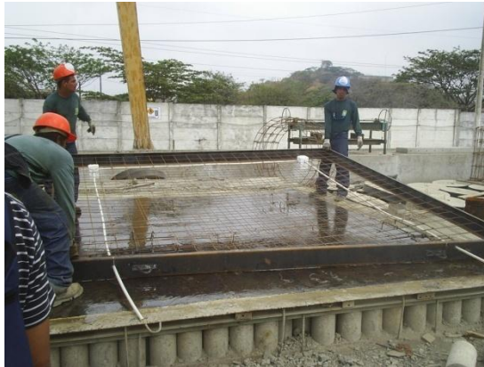
FIG. 5.10 Colocación del panel de manera horizontal sobre la plancha
