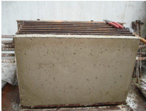
FIGURA 5.6 Desmolde de paneles
