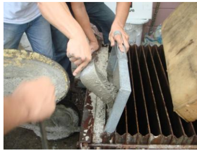
FIGURA 5.2 Colocación del hormigón liviano en el molde
