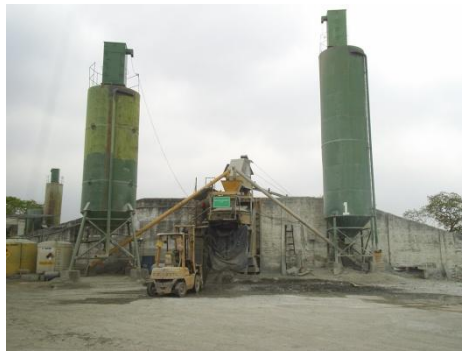
FIGURA 5.14 Dosificación en planta del hormigón liviano
