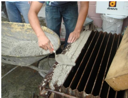
FIGURA 5.5 Retirada de hormigón sobrante
