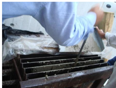
FIGURA 5.3 Compactación de paneles
