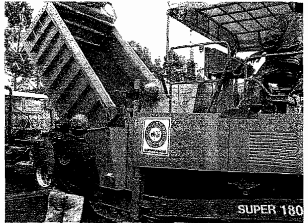
(a) Transporte del HCP y alimentación de la pavimentadora
