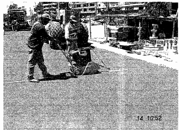
(c) Comprobación de la compactación y corte de juntas
