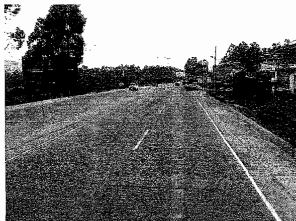
(b) Carpeta de HCP+FT finalizada y trabajos de señalización de la vía
