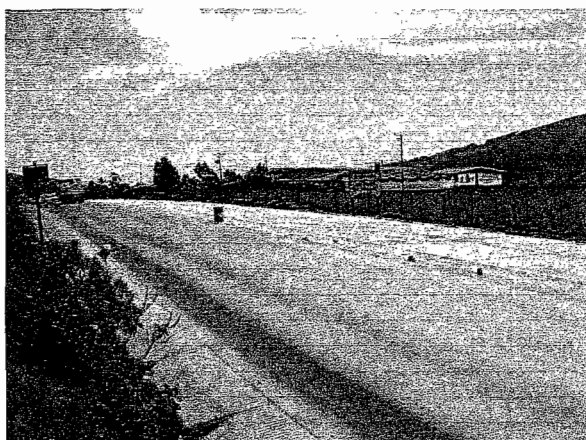
(b) Carpeta de HCP+FT finalizada y trabajos de señalización de la vía
