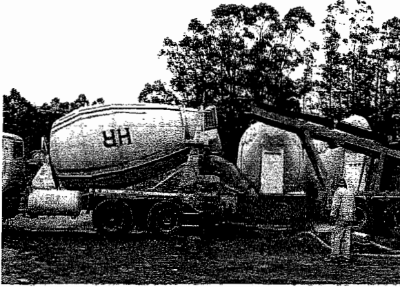
(a) Provisión por medio de mixers y tendido de FT con pavimentadora
