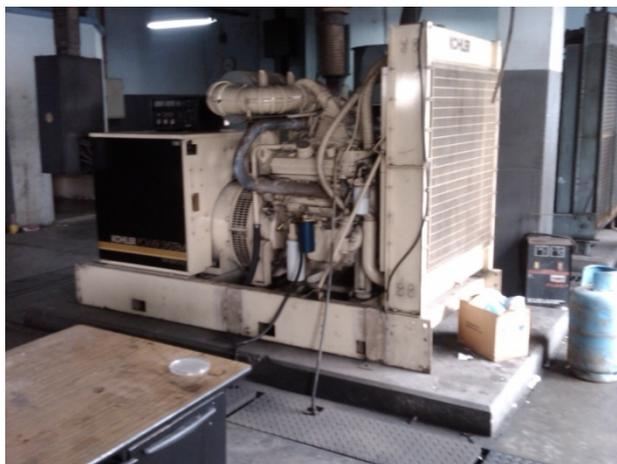
**Fig. 2.4 Generador de emergencia.**
