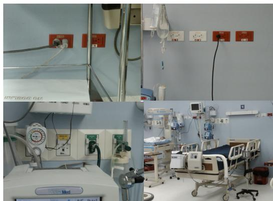
**Fig. 4.2 Vistas de los tomacorrientes y tomas de vacío, aire y oxígeno.**
