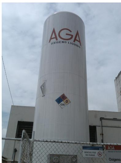
**Fig. 1.20 Tanque de oxígeno líquido.**
