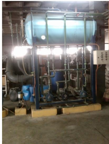
**Fig. 2.3 Tanque de condensado.**
