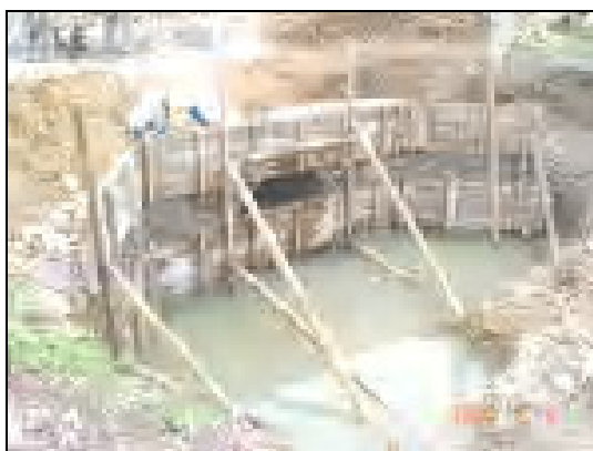
Figura 3.20 Colocación de Encofrados en Muros de Alas
