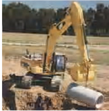
Figura 3.6 Izado de Tubería
