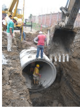
Figura 3.8 Colocación de tubería
