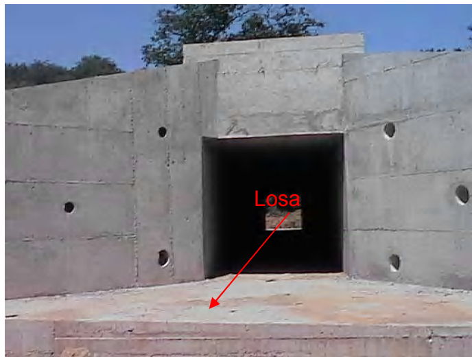
Figura 1.8 Losa de Hormigón
