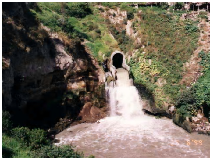
Figura 1.12 Disipador de energía
