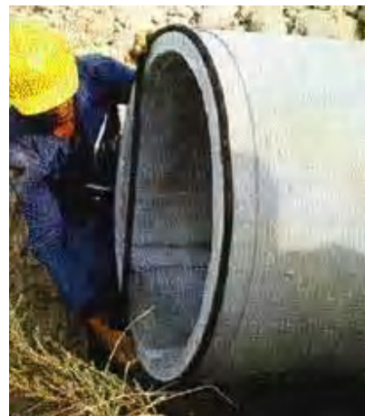
Figura 3.11 Instalación de juntas de neopreno
