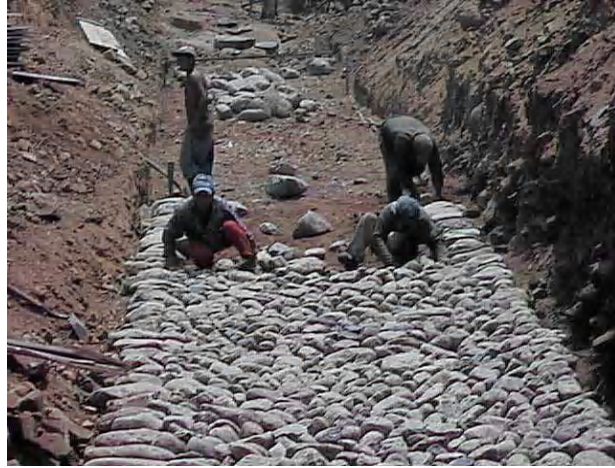
Figura 1.11 Muro de Escollera
