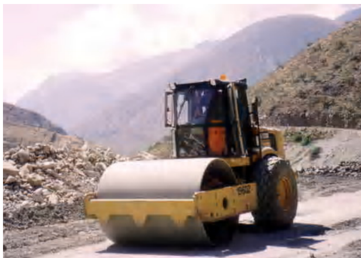
Figura 3.19 Rodillo compactando Capa a Nivel de Subrasante
