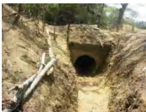
Figura 4.4 Alcantarilla luego de la limpieza
