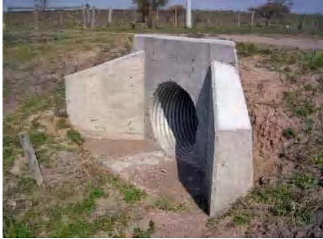
Figura 1.6 Muro de Alas
