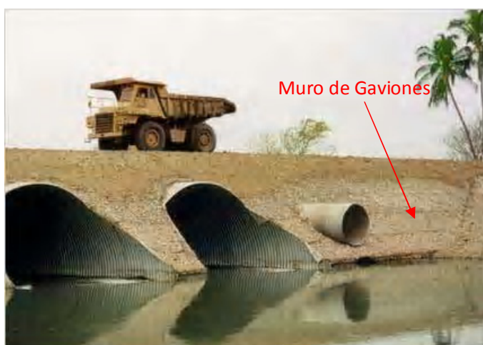
Figura 1.9 Muro de Gaviones
