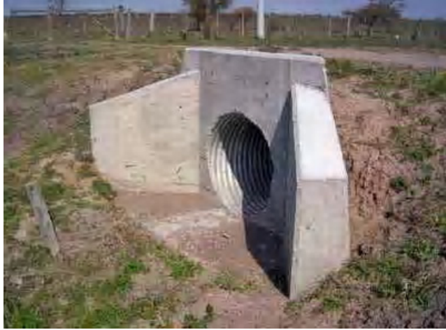
Figura 1.6 Muro de Alas
