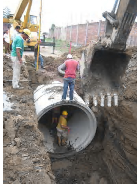
Figura 3.8 Colocación de tubería
