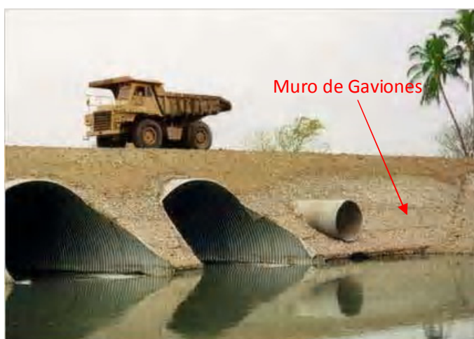
Figura 1.9 Muro de Gaviones
