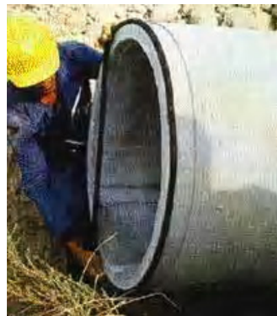
Figura 3.11 Instalación de juntas de neopreno
