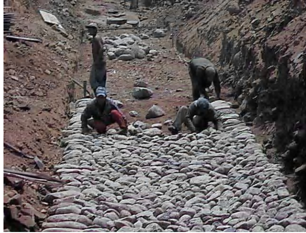
Figura 1.11 Muro de Escollera
