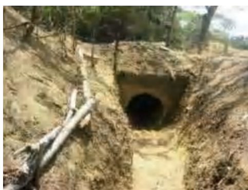
Figura 4.4 Alcantarilla luego de la limpieza
