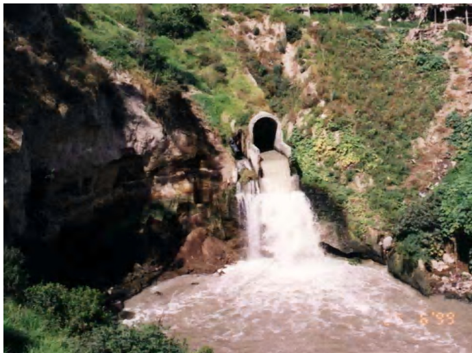
Figura 1.12 Disipador de energía
