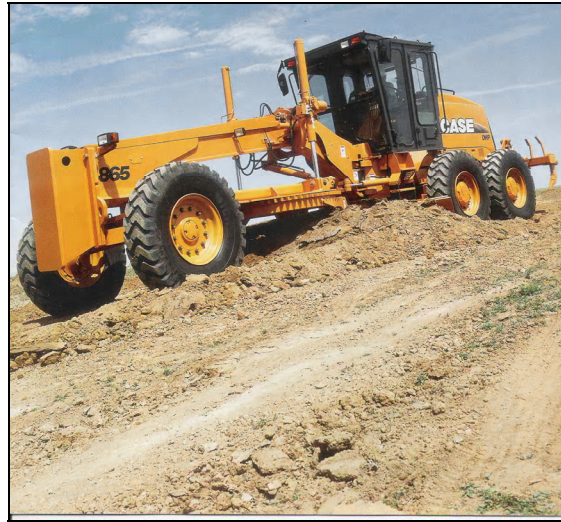
Figura 3.18 Motoniveladora usada para dar el acabado de la capa final
