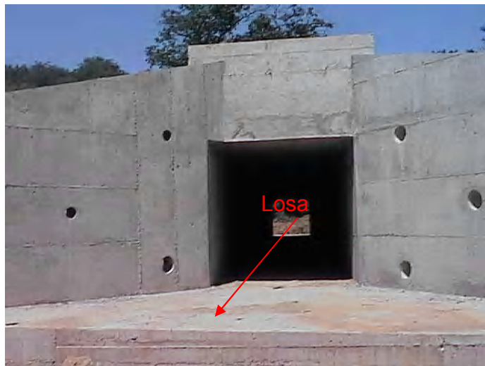
Figura 1.8 Losa de Hormigón
