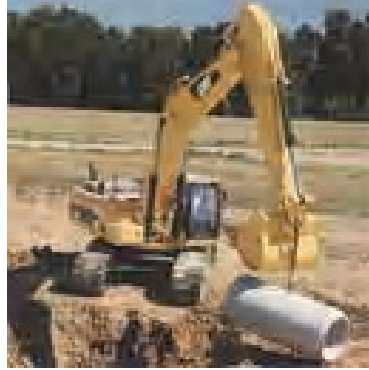
Figura 3.6 Izado de Tubería
