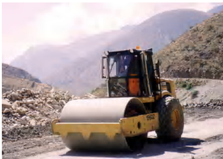
Figura 3.19 Rodillo compactando Capa a Nivel de Subrasante
