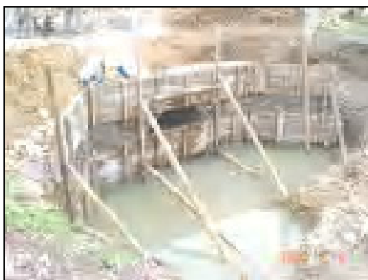
Figura 3.20 Colocación de Encofrados en Muros de Alas
