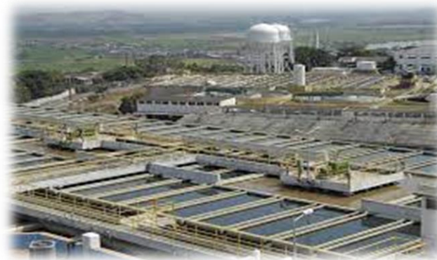
Figura 7 Plantas de Tratamiento de Agua Potable en los que se dosifican químicos para su tratamiento
