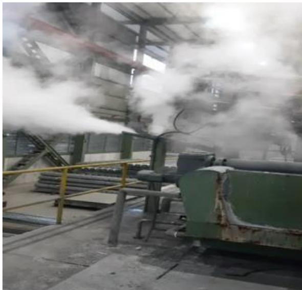
**Figura 2.53 Manguera de presión de vapor rota y remachada por falta de stock de materiales en bodega**
