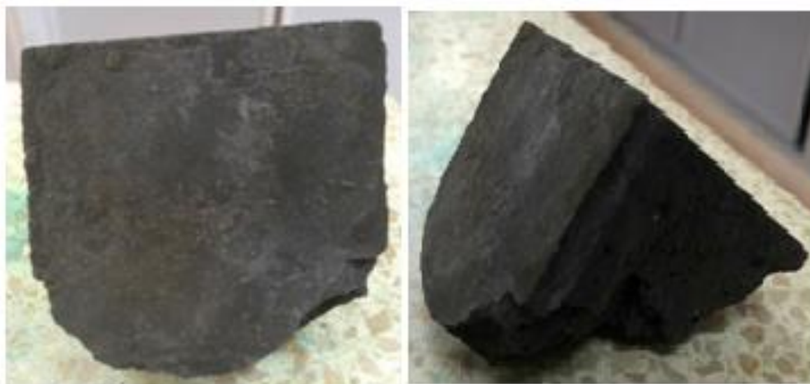
FIGURA A.5 EFLORESCENCIA DE LA MEZCLA 0,2/24/132 NIVEL 2
