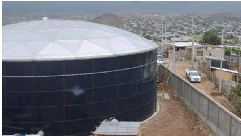
Figura 9: Reservorio de agua potable
