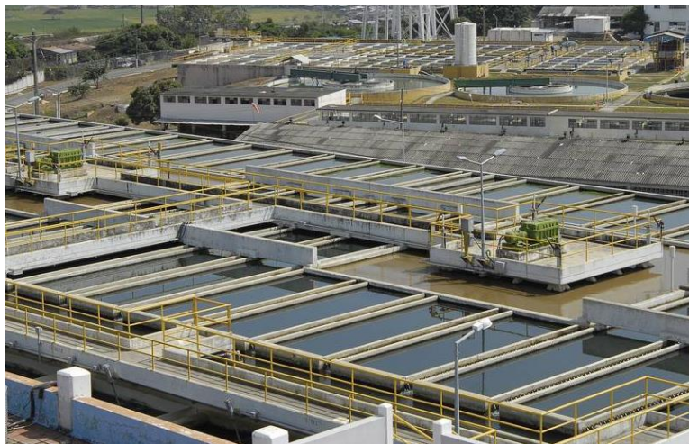
Figura 8: Planta de tratamiento de agua potable tipo convencional
