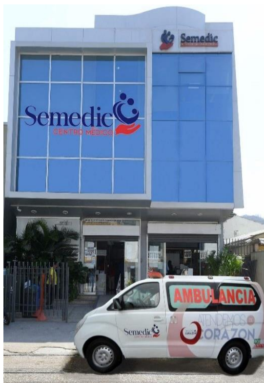
Figura 2. Edificio Semedic Urdesa
