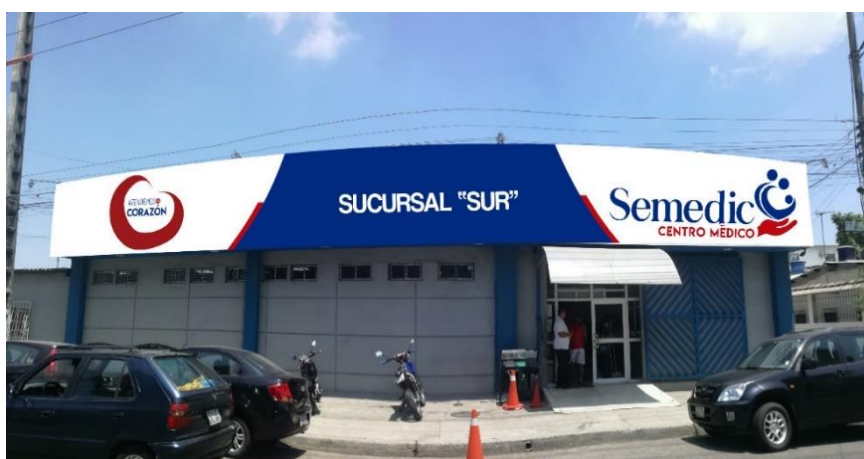
FIGURA 5. Edificio Semedic Sur
