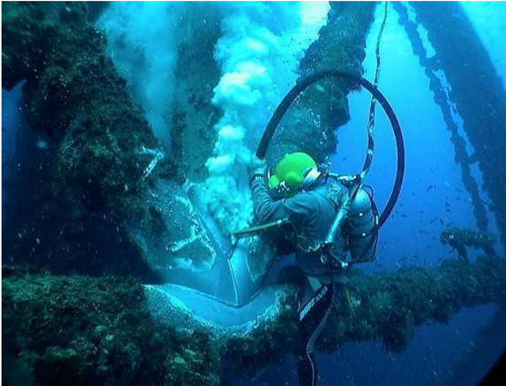
Ilustración 29. Limpieza de estructura submarina en plataforma.
